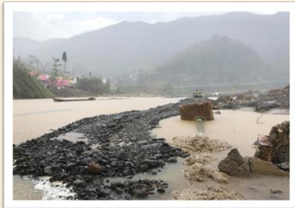
TRONCAL SANITARIA COMERÍO
